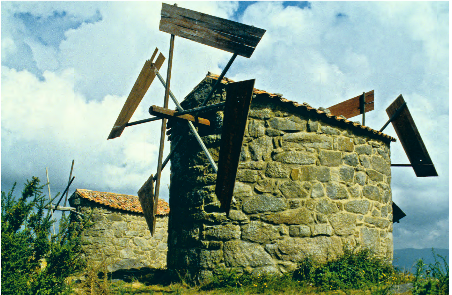
Muíños de Catoira , únicos de Europa de estrutura fixa con dobre xogo de pas, que aproveitan a forza dos ventos aínda que cheguen de direccións diferentes. Os muíños de vento foron moi abundantes, sobre todo pola costa e en zonas expostas e con escaseza de correntes de auga. No estudo de Begoña Bas ("Muíños de Marés e de Vento en Galiza") faise referencia a 120.
