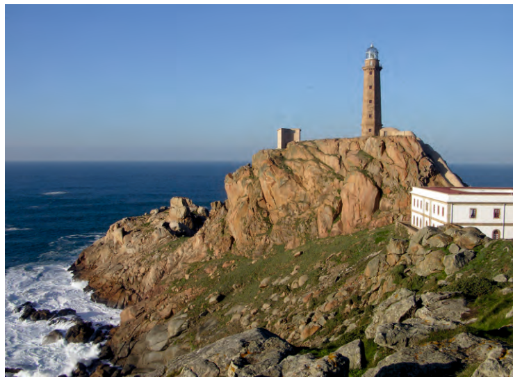
Faro de Cabo Vilán (Camariñas), o primeiro do Estado que funcionou con luz eléctrica, en 1896.
