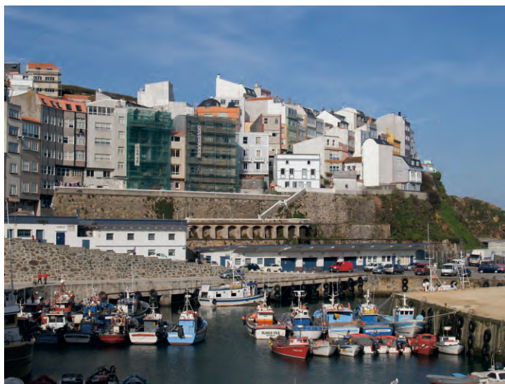
Porto de Malpica. Atópase no corazón da costa da Morte. Ten unha estrutura moi complexa cun grande dique de abrigo e zonas que se poden pechar, necesarias para protexer as embarcacións dos fortes temporais.
