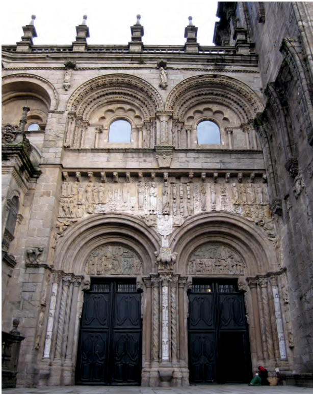
Fachada das Praterías
